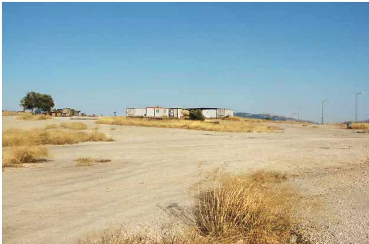
Αποηλώσεις παλαιών εγκαταστάσεων - Αύγουστος 2008
