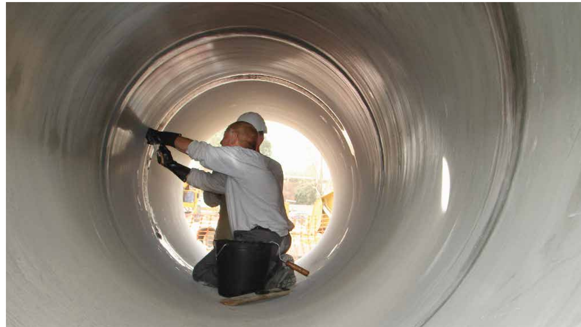
Εργασία σύνδεσης στον κεντρικό αγωγό νερού Ψύξης - Ιούνιος 2010
