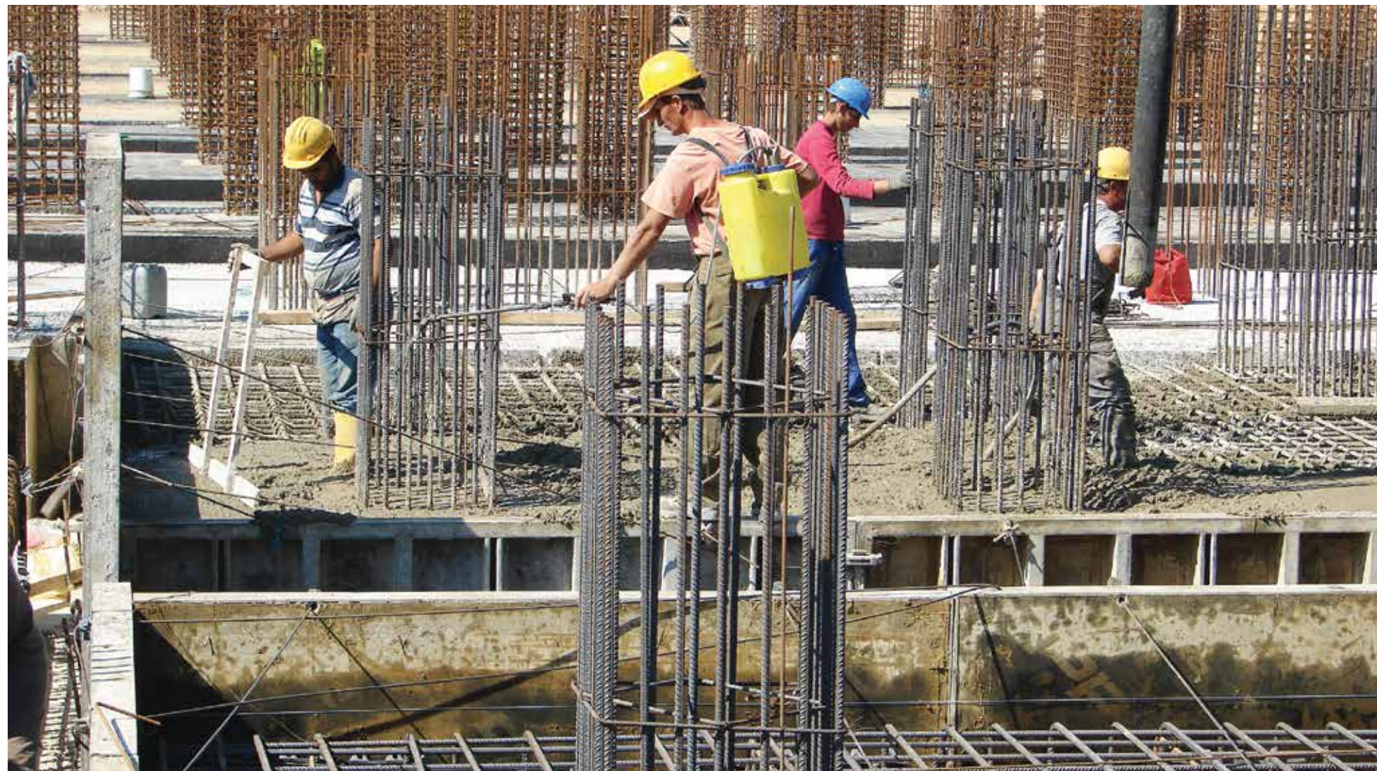
Εργασία σκυροδέτησης θεμελιώσεων στη Μονάδα 33 - Οκτώβριος 2009
