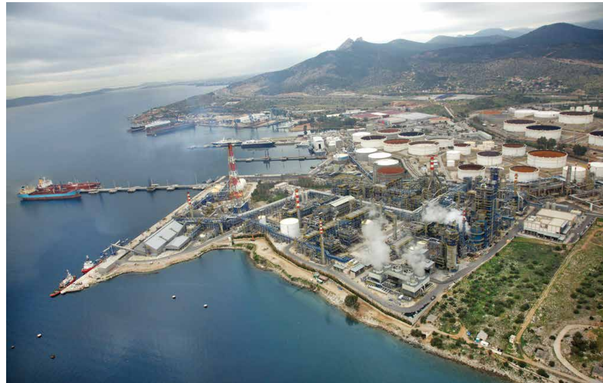
Αεροφωτογραφία του Νέου Διυλιστηρίου από την Ανατολή - Ιανουάριος 2013
