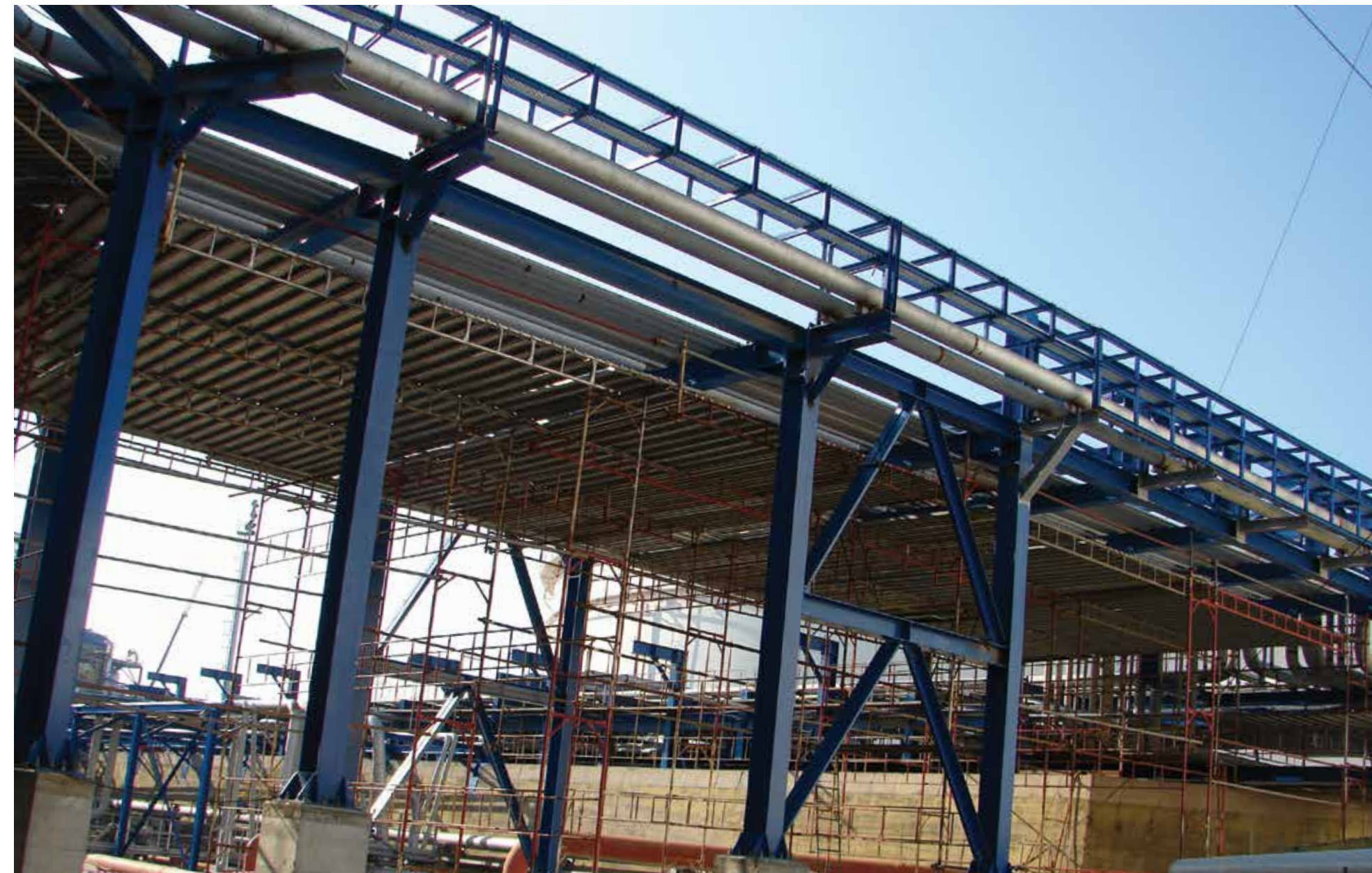
Κατασκευή Σωληνοδιαδρόμων Έργου Διασύνδεσης - Νοέμβριος 2011
