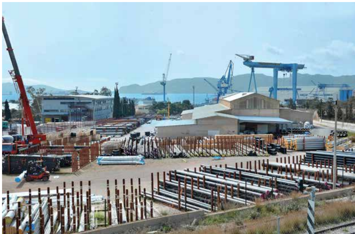
Κεντρική Αποθήκη Υλικών Σωληνώσεων Έργου στην Ελευσίνα
