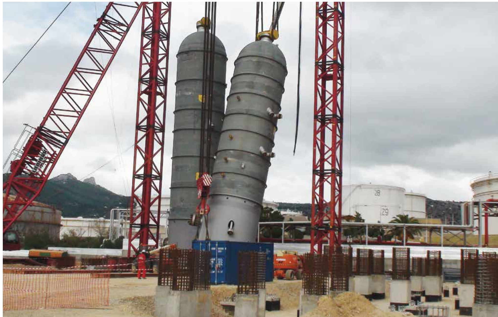
Ανέγερση Αντιδραστήρων 1 & 2 Μονάδας 34 - Οκτώβριος 2009
