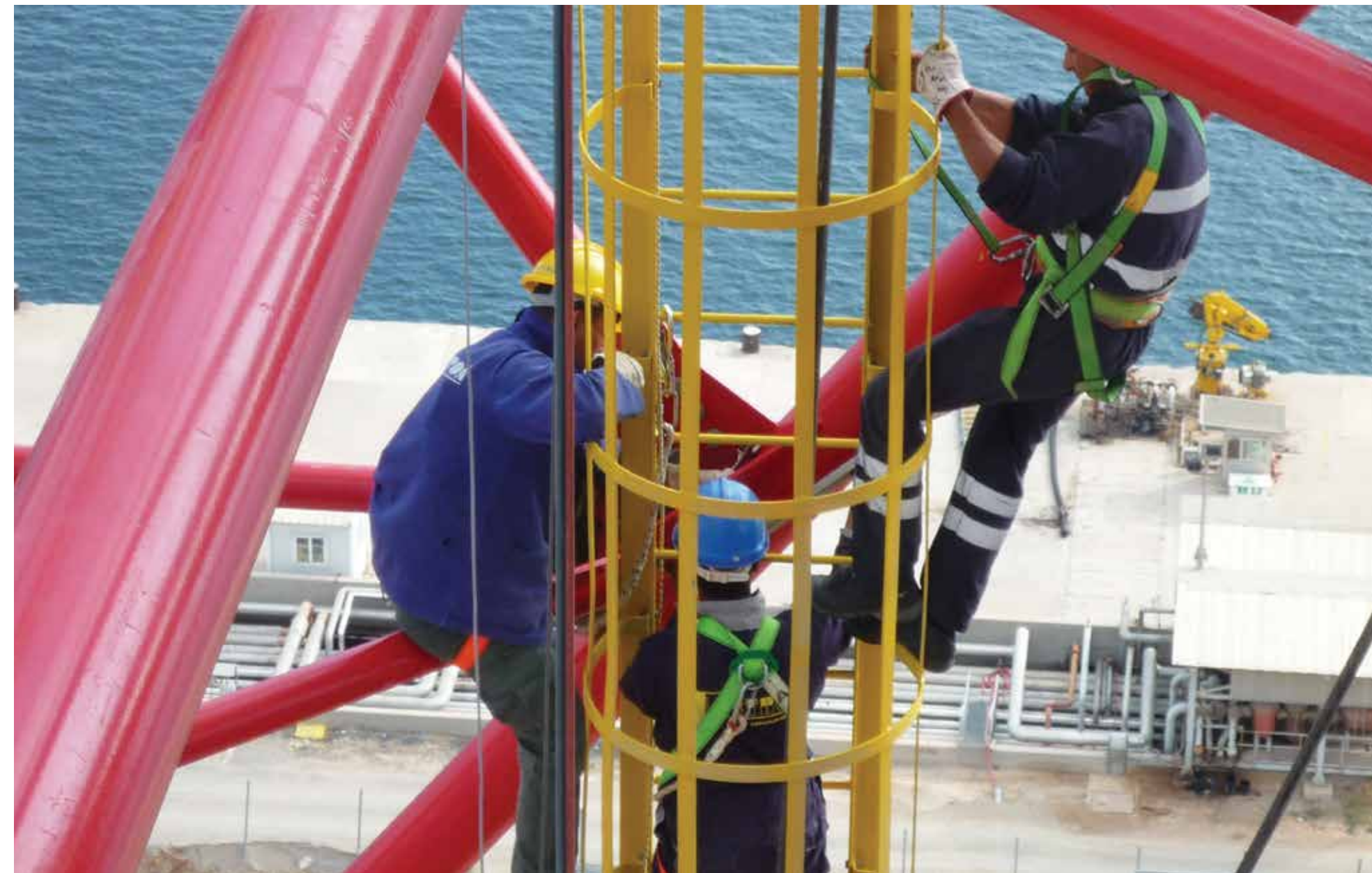
Ανέγερση Πυρσού - Εργασία στα 100μ ύψος - Οκτώβριος 2010
