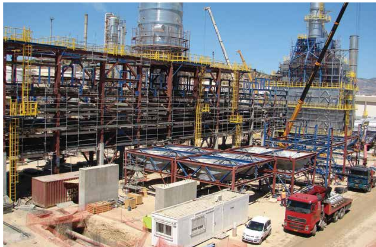
Γενική άποψη Μονάδας 31 - Σεπτέμβριος 2010
