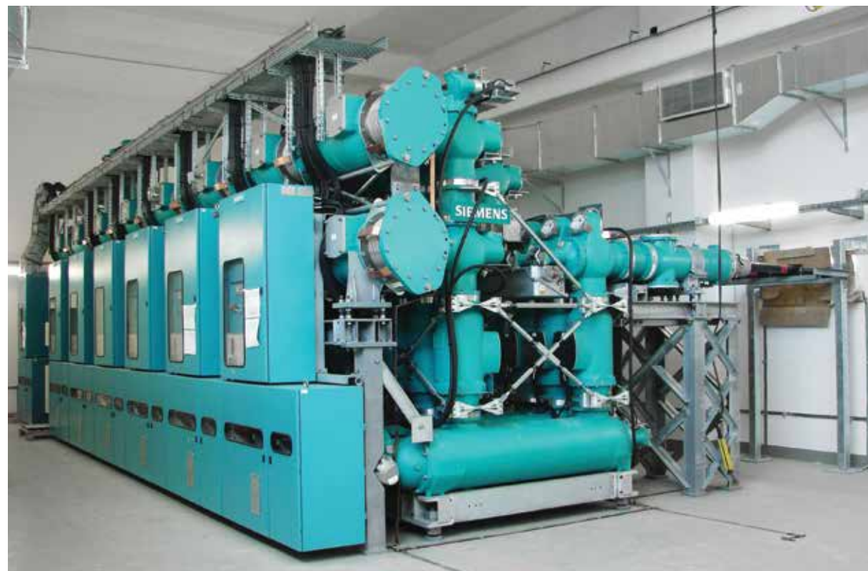
Εγκατάσταση Μετασχηματιστών Υψηλής Τάσης 150KV - Απρίλιος 2011
