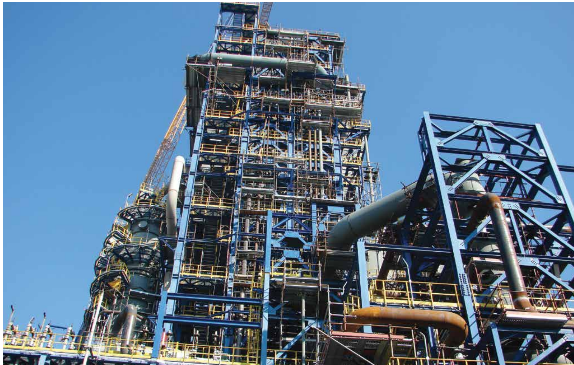
Ανέγερση Σιδηροκατασκευής D - Νοέμβριος 2011
