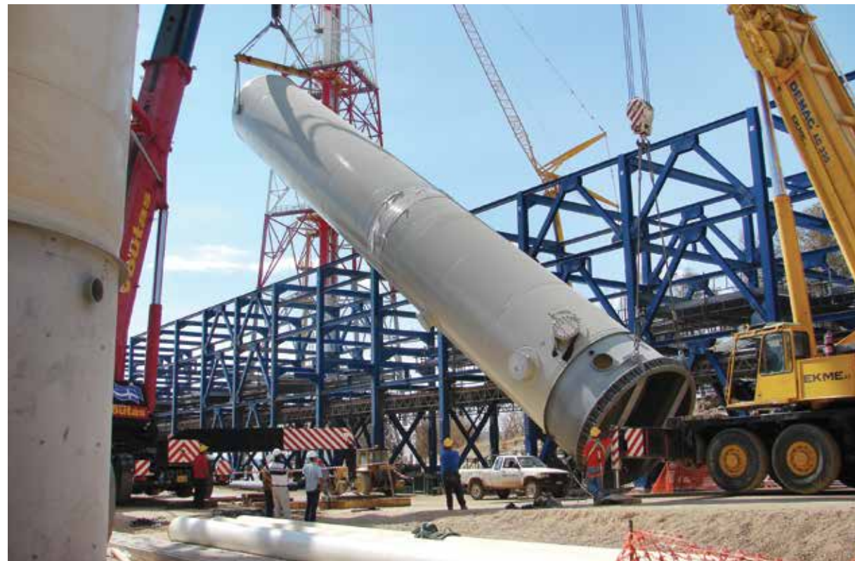
Τοποθέτηση δοχείου στη Μονάδα 33 - Σεπτέμβριος 2010
