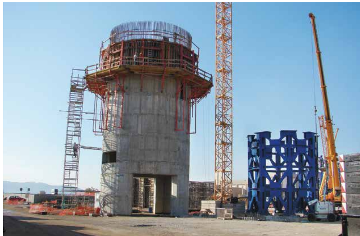
Βάση του Σιλό Κωκ Μονάδας 32 - Σεπτέμβριος 2010
