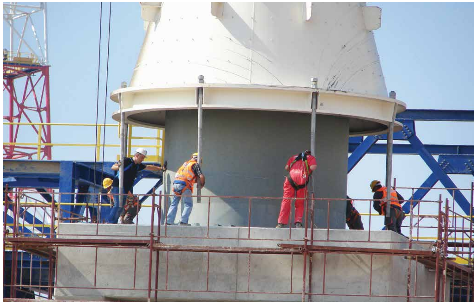
Τοποθέτηση Αντιδραστήρα Μονάδας 32 - Αύγουστος 2010
