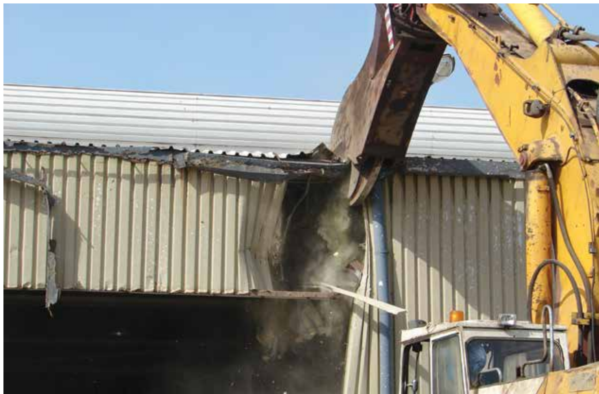
Η αποξήλωση των παλαιών αποθηκών αρχίζει - Μάιος 2008 Start of Demolition of old warehouses - May 2008
