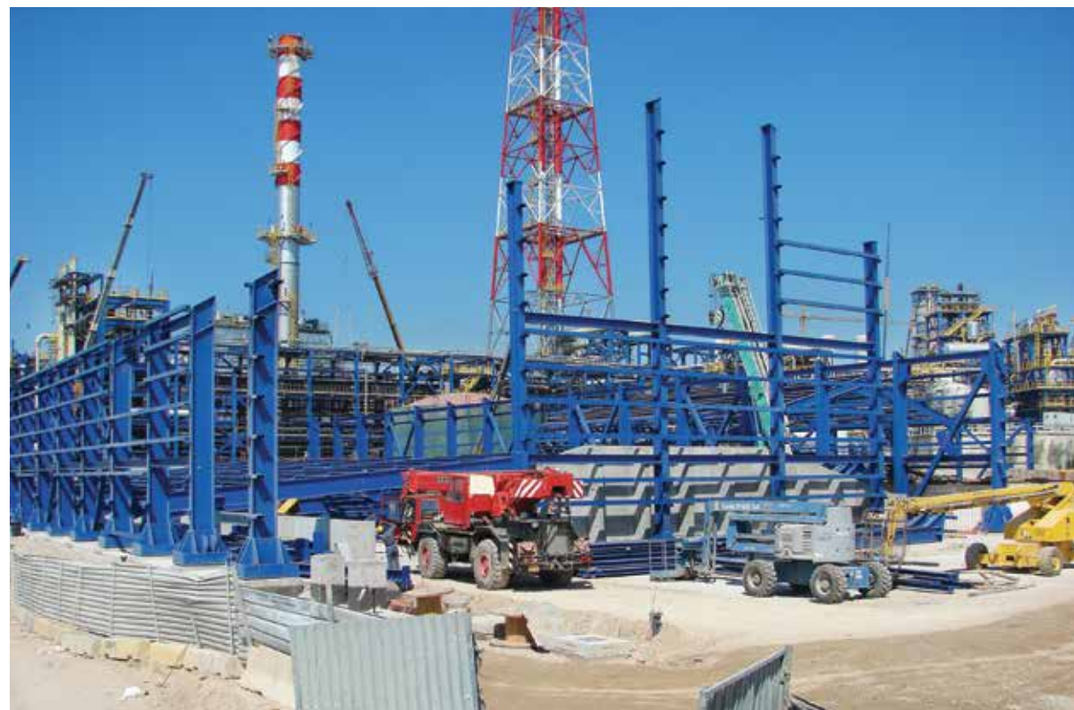
Αποθήκη Στερεού Θειαφίου - Σεπτέμβριος 2011 / Οκτώβριος 2012
