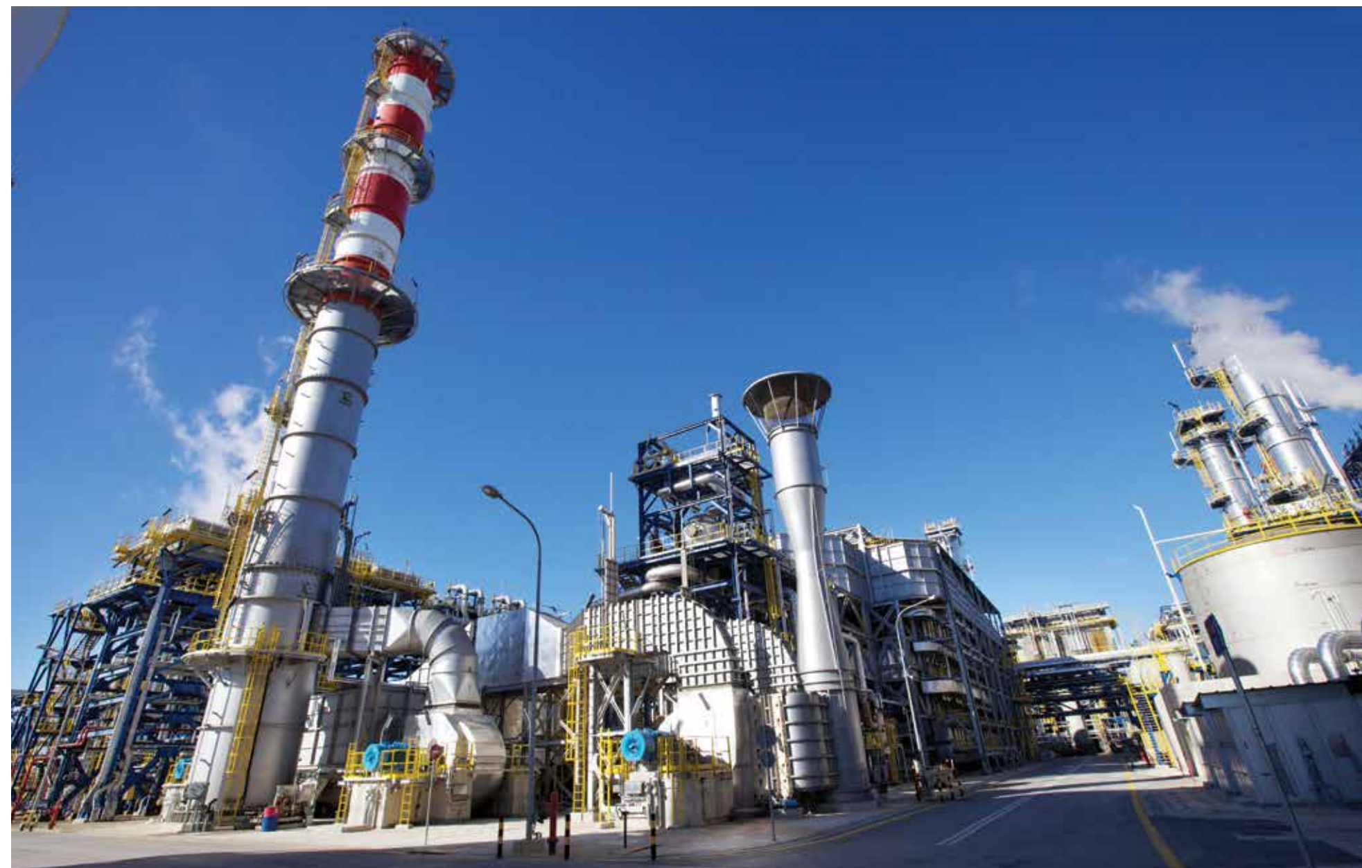
Ανατολική άποψη Μονάδας 33 - Δεκέμβριος 2012 East View of Unit 33 - Stack & Tubular Reformer - December 2012
