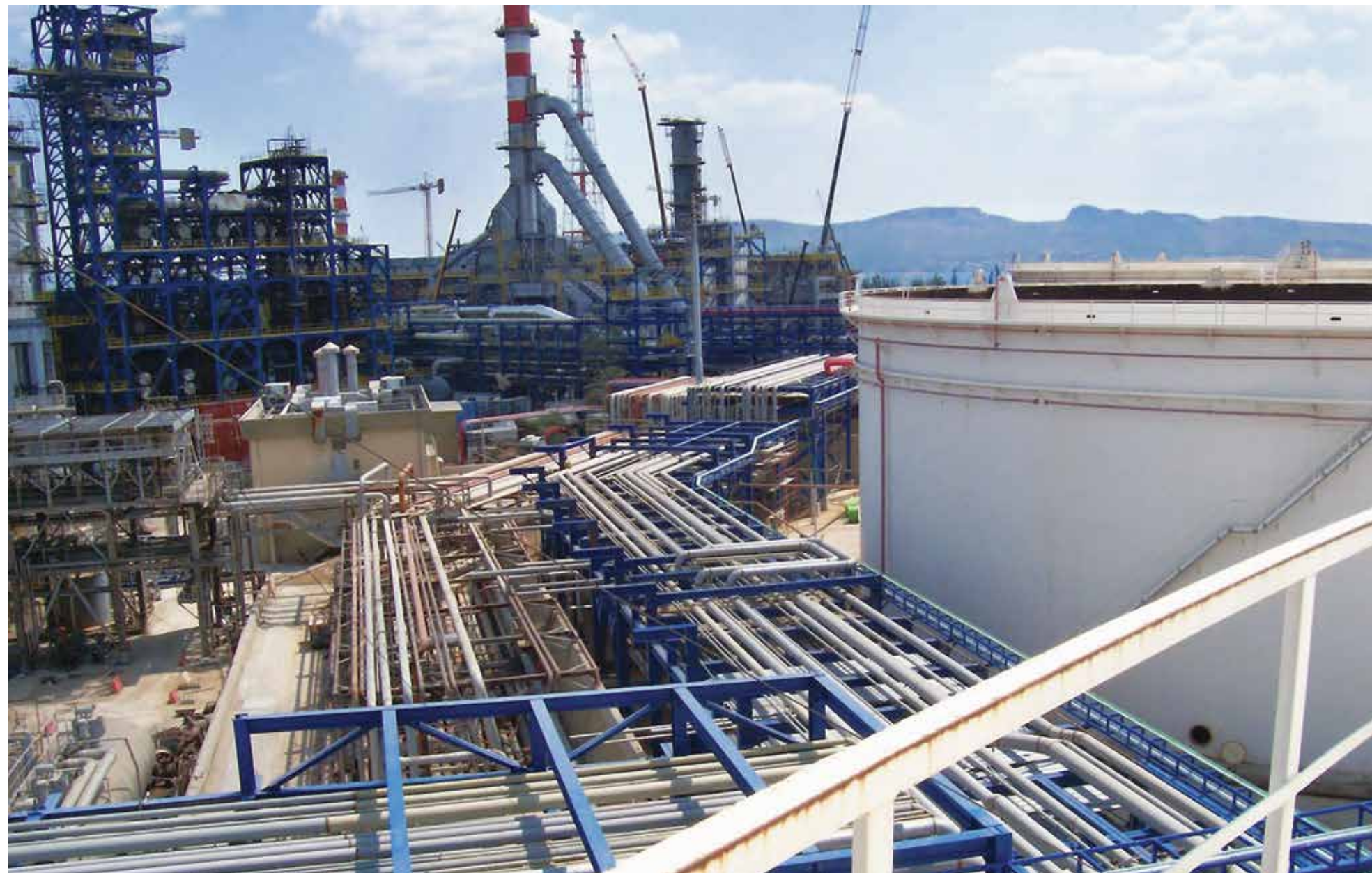
Κατασκευή Σωληνοδιαδρόμων Έργου Διασύνδεσης - Αύγουστος 2011
