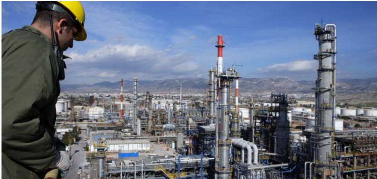
Άποψη του Διυλιστηρίου Ασπρόπυργου
