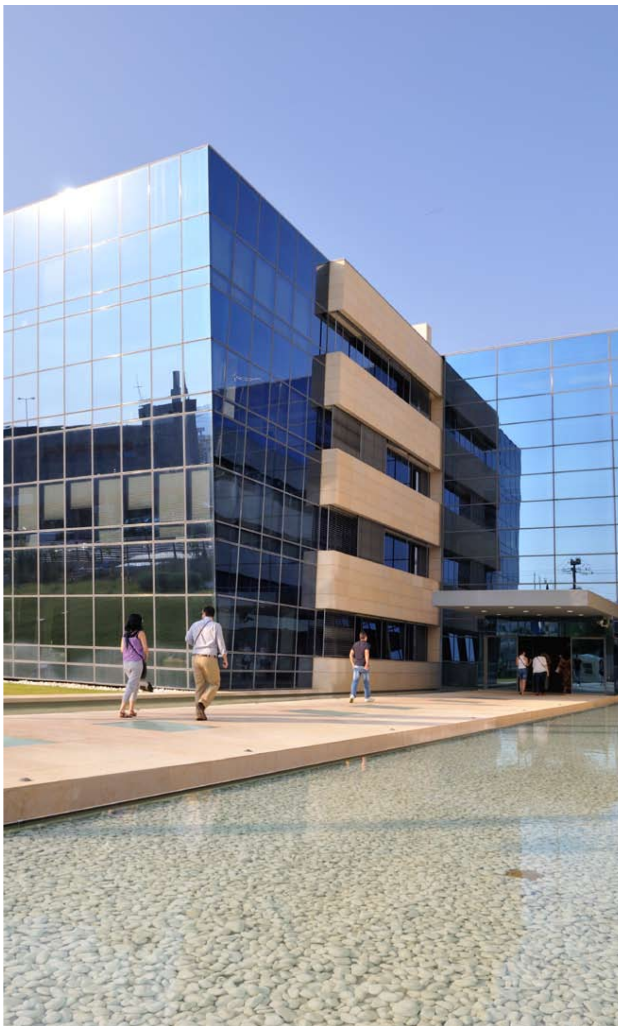
Κτίριο Κεντρικών Γραφείων Αμαρουσίου
