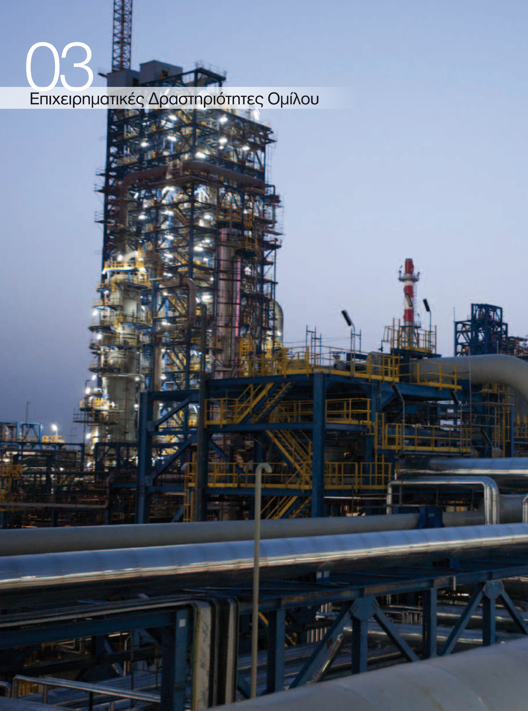
Unit-32 - Αντιδραστήρας Θερμικής Πυρόλυσης - Πύργος Διύλισης & Υπερθερμαντής Ατμού Διυλιστηρίου Ελευσίνας
