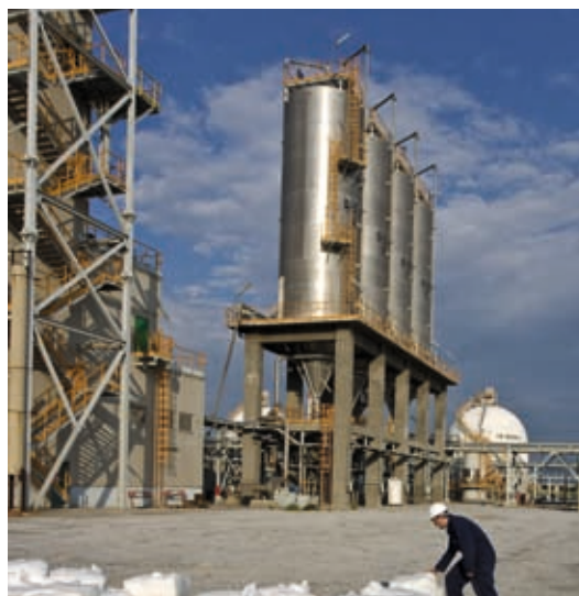
Άποψη εργοστασίου πετροχημικών στη Θεσσαλονίκη
