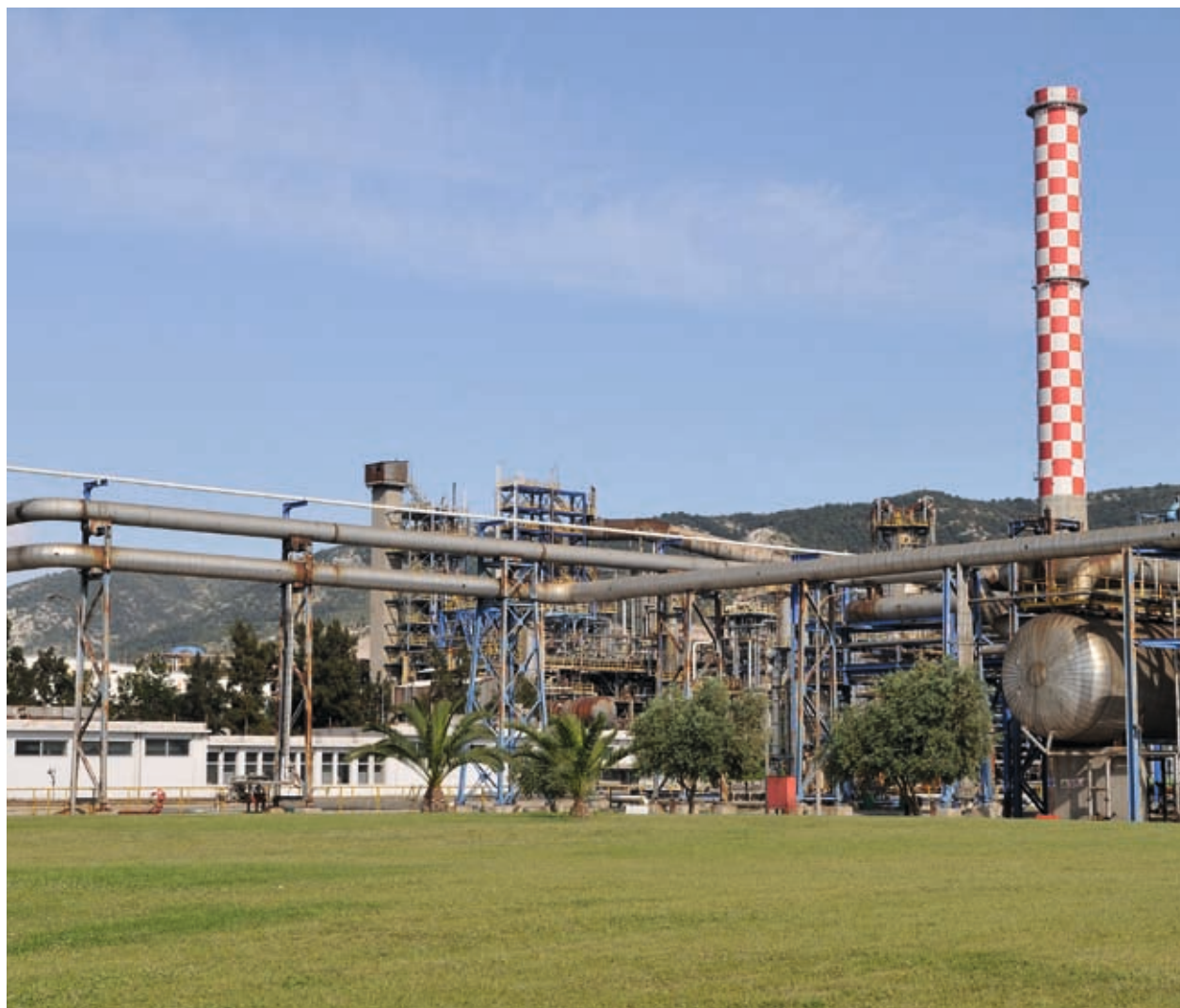
Άποψη του διυλιστηρίου Ασπροπύργου
