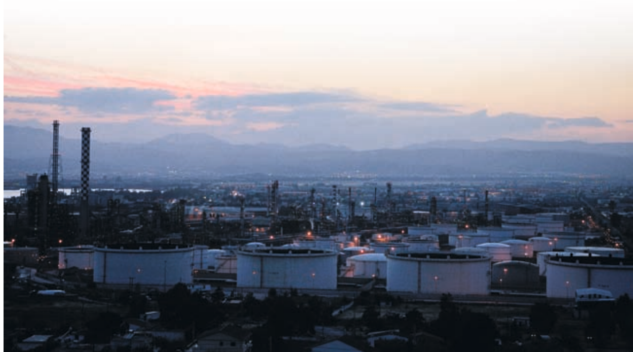
Άποψη του διυλιστηρίου Ασπροπύργου
