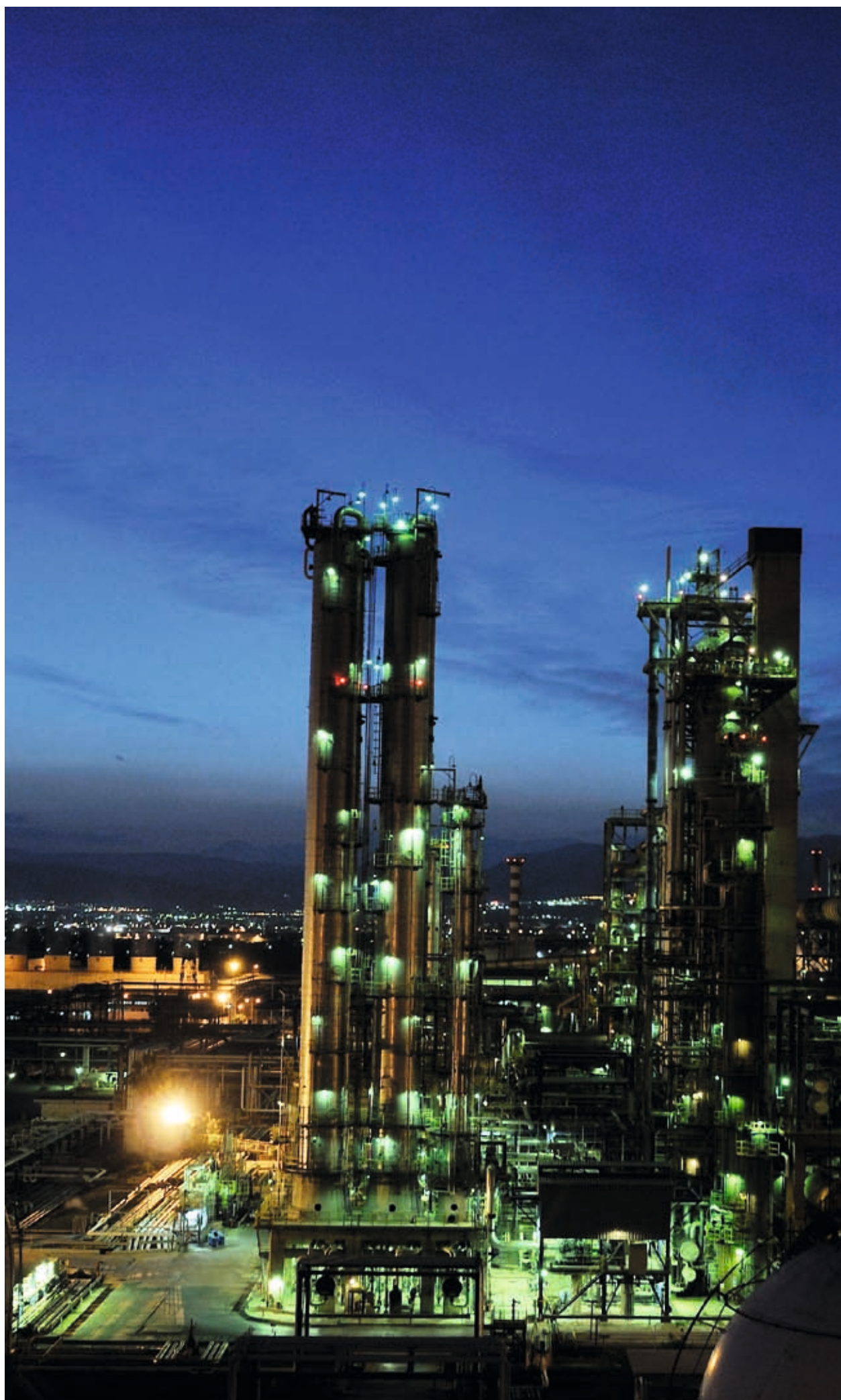
Αποψη του διυλιστηρίου Ασπροπύργου
